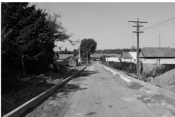
Сейчас идёт капитальный ремонт дорожного полотна на улице Берзарина: ведутся укладка выравнивающего слоя и устройство бордюрного камня на протяжении всей улицы.
